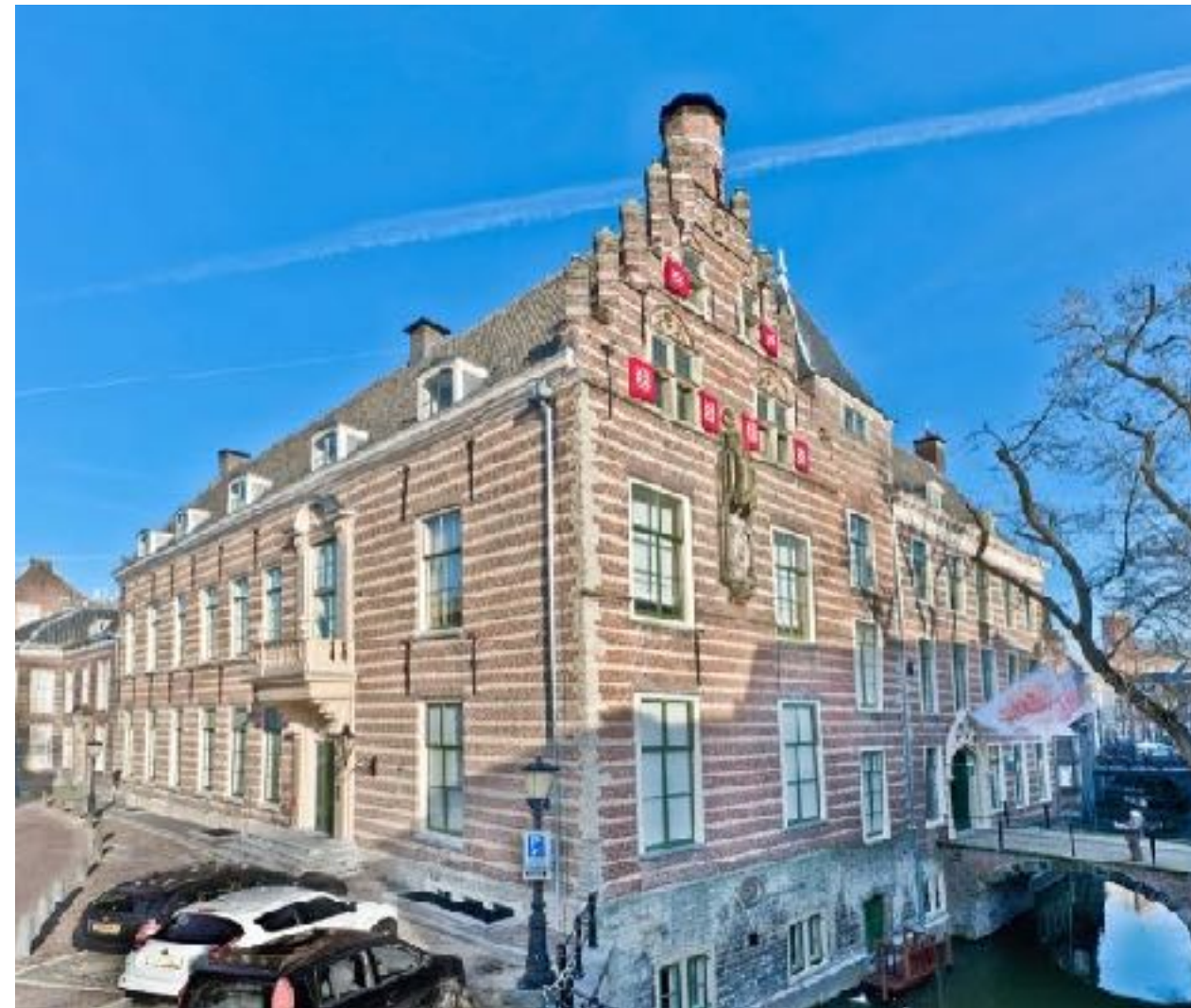
Restauratie Paushuize, Utrecht (Provincie Utrecht)
